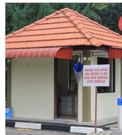
PONDOK PENGAWAL KESELAMATAN DI KOMPLEKS
